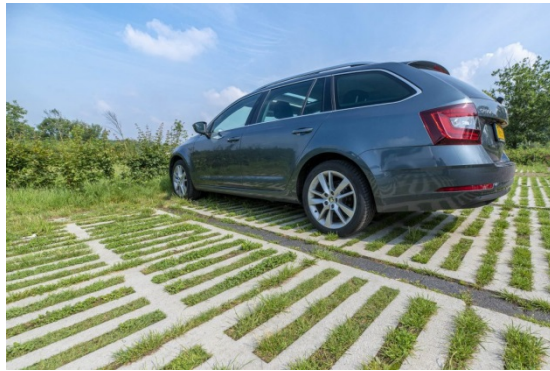
Fig. 27 en 28. Voorbeelden halfverharding en/of half open verharding.
