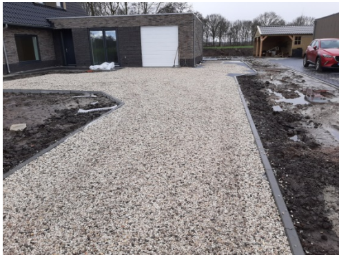
Fig. 27 en 28. Voorbeelden halfverharding en/of half open verharding.
