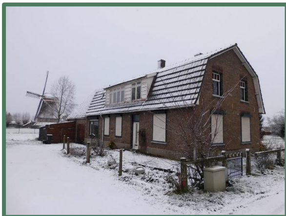
Overzicht zuidwestzijde woning
