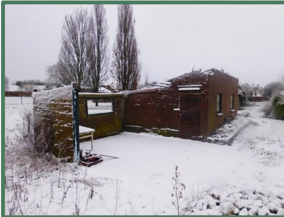
Overzicht noordwestzijde bijgebouw
