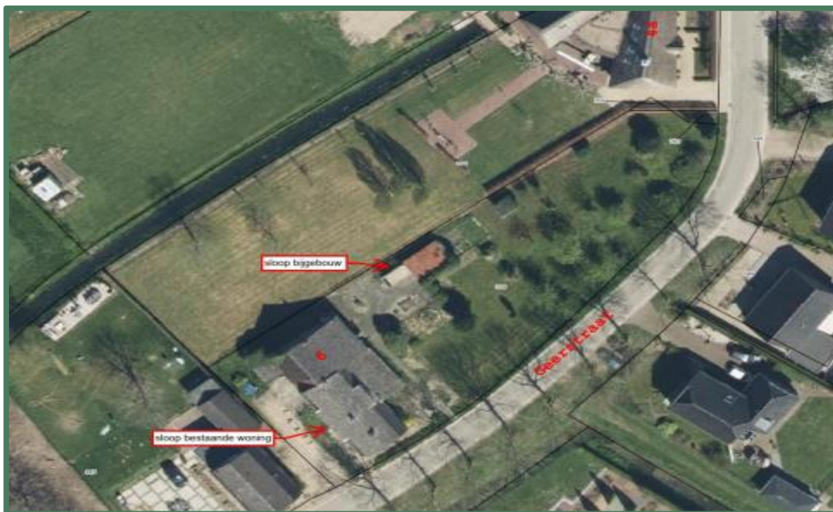
Huidige situatie. Te slopen dubbele woning en bijgebouw in rood aangegeven. Bron: Willems Winssen
