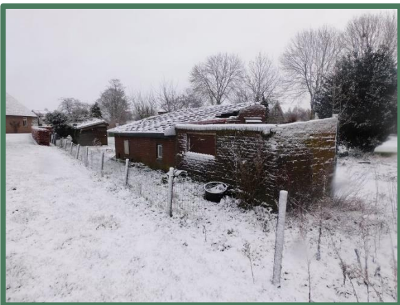
Overzicht zuidwestzijde bijgebouw
