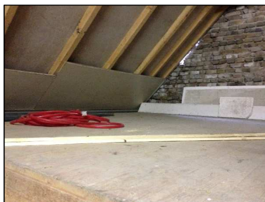
Foto 4. Zolder van de aangebouwde schuur
