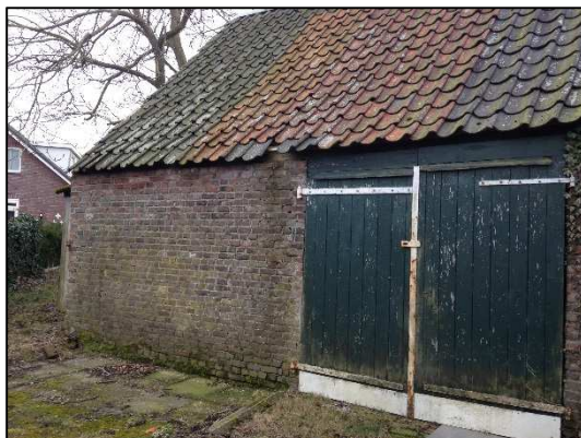
Foto 5. Buitenzijde te slopen boerderij
