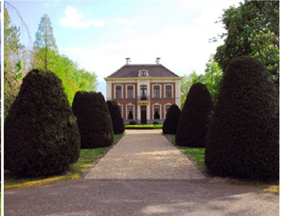
Zicht op villa Roozenburg vanaf de Pastoor van der Marckstraat
