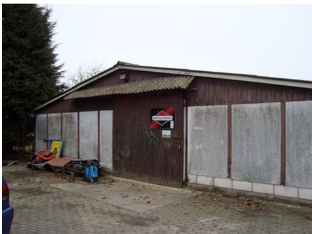
Foto 1. Te slopen grote schuur.
