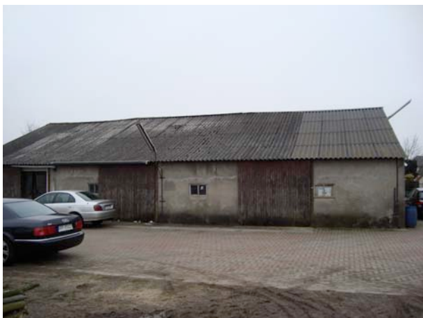
Foto 5. Te slopen kleine schuur.
