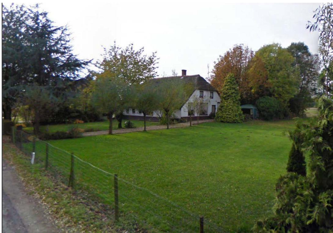
Fig. 2.7: De huidige bebouwing binnen het plangebied (bron: http://maps.google.nl - streetview).
