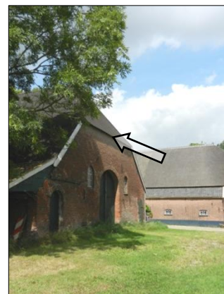
Figuur 1: Aan de kopgevels komen openingen waardoor de zolderruimte bereikbaar blijft voor vleermuizen.
