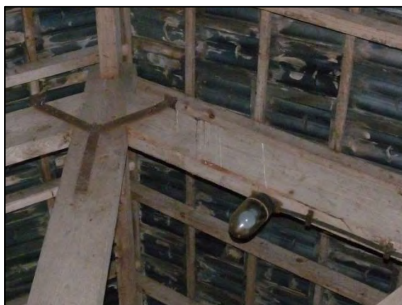
Figuur 11. Krijtsoren op de balken.
