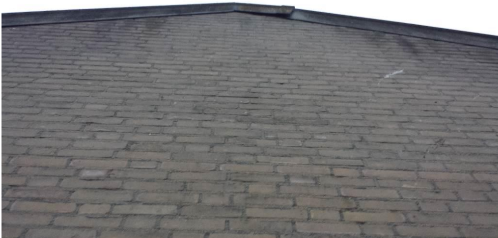
Figuur 4. Oostkant van schuur C, waar lood langs dakrand een klein beetje kiert.
