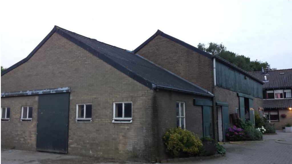
Figuur 3. West en noordkant van schuur B. Net zichtbaar bij het woonhuis is de buitenlamp die 's avonds een deel van de schuur verlicht.
