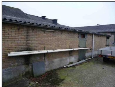
Figuur 4. Schuur B
