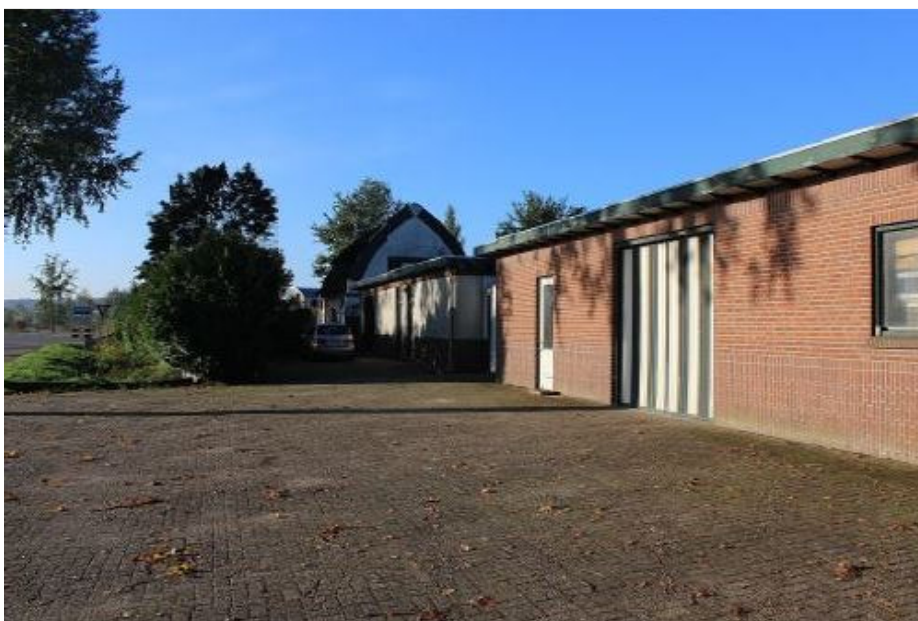
Afbeelding 17: Foto van het plangebied van noord naar zuid. De achterzijde van het gemeentelijk monument aan de Van Heemstraweg is zichtbaar. (bron: opdrachtgever, 2016)
