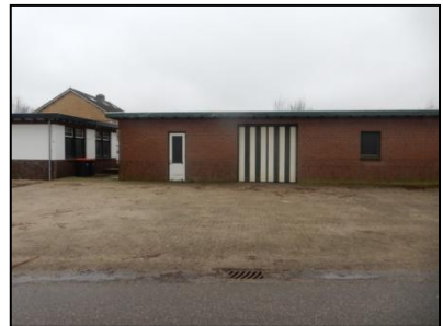
Figuur 5. Te slopen schuur.
