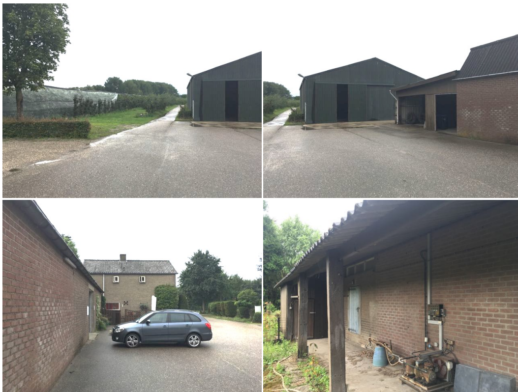
Impressie van het plangebied. De bovenste foto's tonen de te slopen schuren en het te behouden bijgebouw. Op de onderste foto's staat het overige deel van het erf afgebeeld. Deze gebouwen blijven staan.
