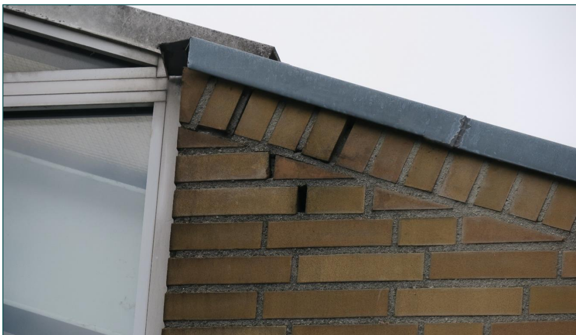
Figuur 3.2 Stootvoeg in het pand aan de Wilhelminalaan 45.
