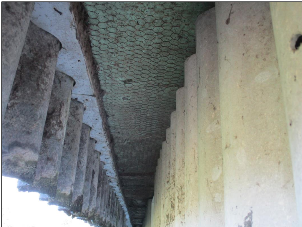
Figuur 3 Stalventilatie welke over de gehele lengte van de stal is afgedicht met kippengaas.
