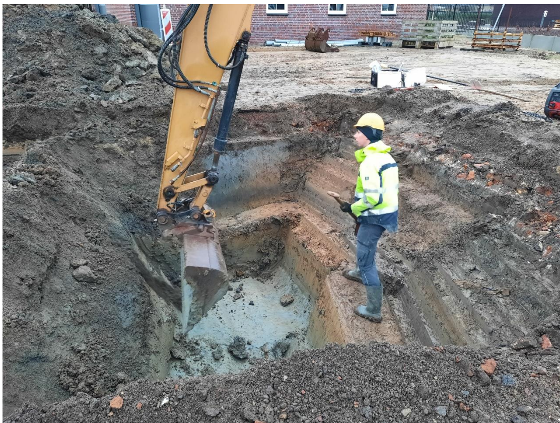
Figuur 3. De aanleg van vlak 3 in werkput 3.
