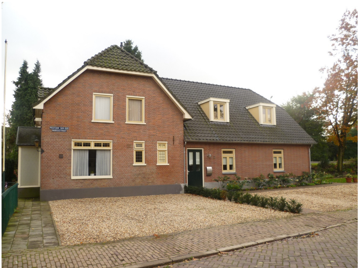
de bebouwing na de verbouw in 2009 tot 2 zelfstandige woonhuizen
