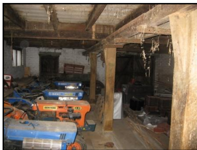
Figuur 7. Onderverdieping schuur.
