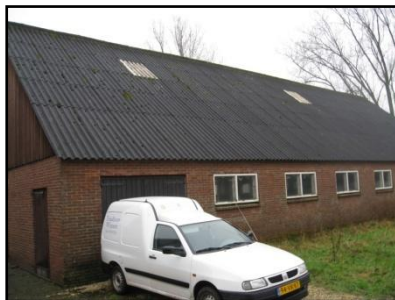
Figuur 3. Te renoveren schuur.
