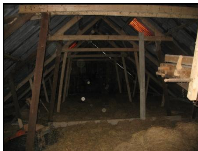
Figuur 6. Zolder schuur Plakstraat.
