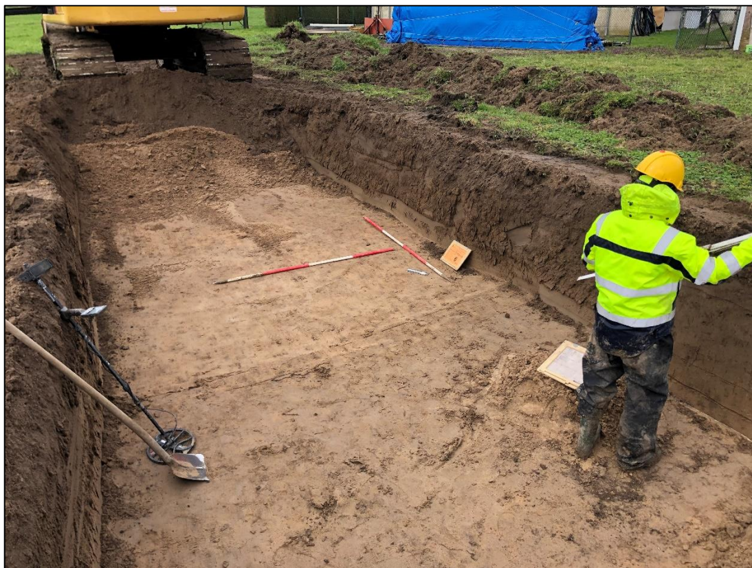
Figuur 7. Aanleg en documentatie van werkput 2, vlak 2.
