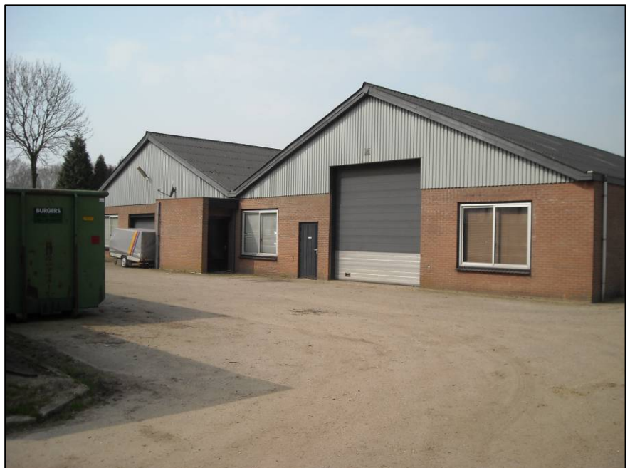
Te slopen opstal bouwlocatie
