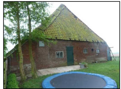
Figuur 5. Achterzijde van de schuur.
