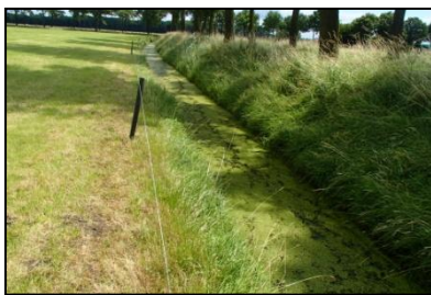
Figuur 6. Afwateringssloot langs de perceelsgrens (Ficarystraat).
