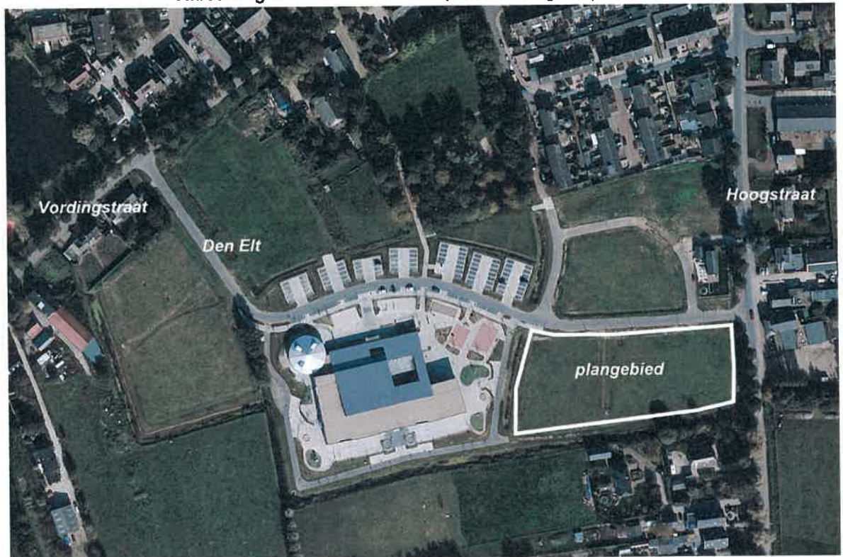
Afbeelding 2: luchtfoto van locatie (bron: live.bing.com)
