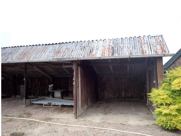
Foto 11: Links, het gebouw is aan één zijde volledig open
