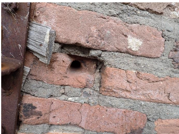
Foto 19: Links, ondiep gat in de muur afkomstig van een schroef met plug voor de bevestiging van een oud hekwerk.
