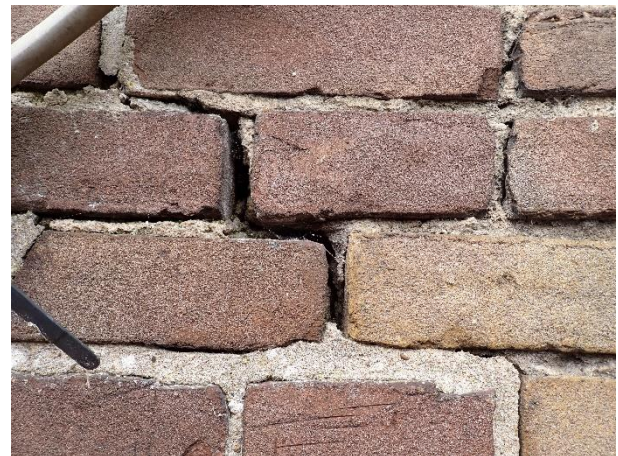
Foto 7: Links, bij één van de zijden van het huis zijn de bakstenen zichtbaar. Er zitten meerdere kieren en spleten in. Er is geen spouwmuur.
