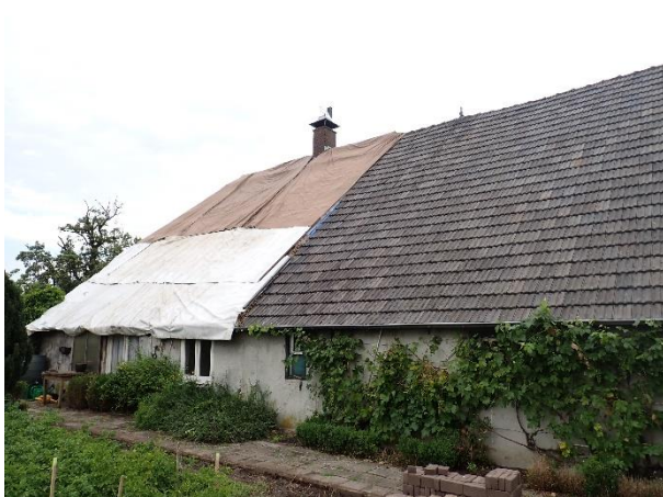
Foto 5: Links, het dak van de woning bestaat gedeeltelijk uit dakpannen en gedeeltelijk uit riet. Het deel met riet is op dit moment afgedekt.
