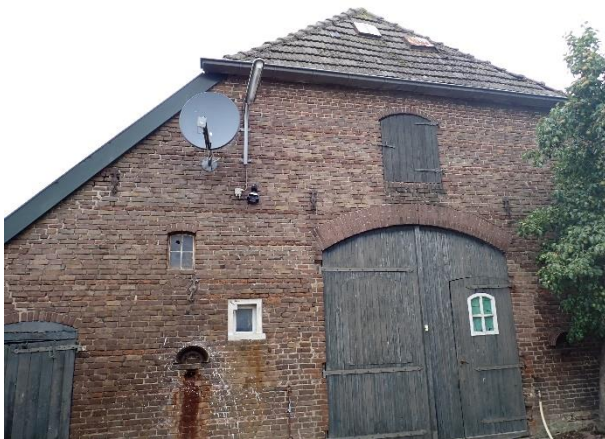
Foto 7: Links, bij één van de zijden van het huis zijn de bakstenen zichtbaar. Er zitten meerdere kieren en spleten in. Er is geen spouwmuur.
