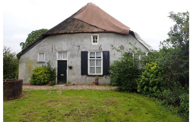
Foto 7: Links, bij één van de zijden van het huis zijn de bakstenen zichtbaar. Er zitten meerdere kieren en spleten in. Er is geen spouwmuur.
