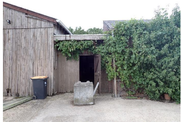
Foto 23: Links, de buitenzijde van de schuur. Het bestaat uit enkelwandig hout.
