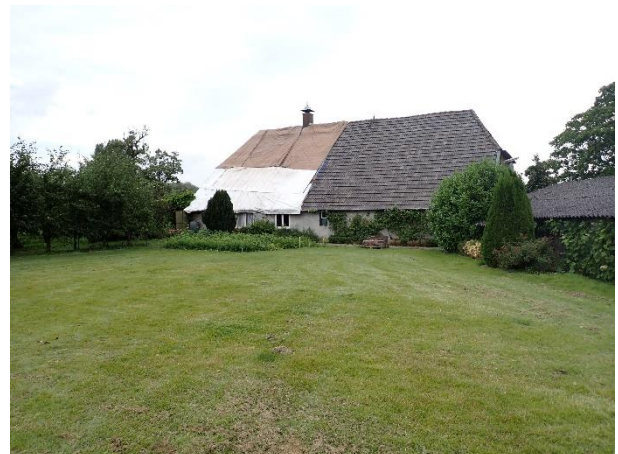
Foto 5: Links, het dak van de woning bestaat gedeeltelijk uit dakpannen en gedeeltelijk uit riet. Het deel met riet is op dit moment afgedekt.
