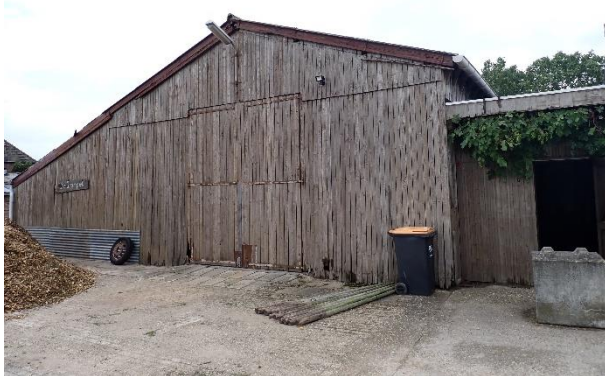
Foto 23: Links, de buitenzijde van de schuur. Het bestaat uit enkelwandig hout.
