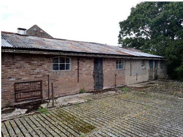
Foto 17: Links, er bevindt zich een mestput naast het gebouw. Het dak van het gebouw bestaat uit golfplaten.
