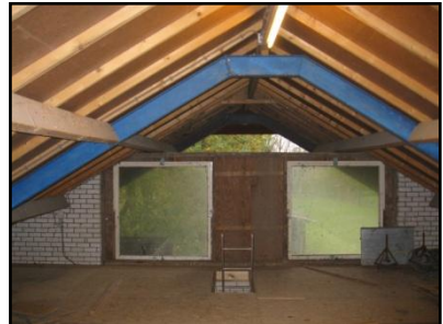
Figuur 5. Zolder schuur.
