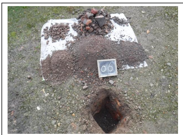
Foto 5. Asbestinspectiegat + Opgegraven en gezeefd materiaal gat 06
