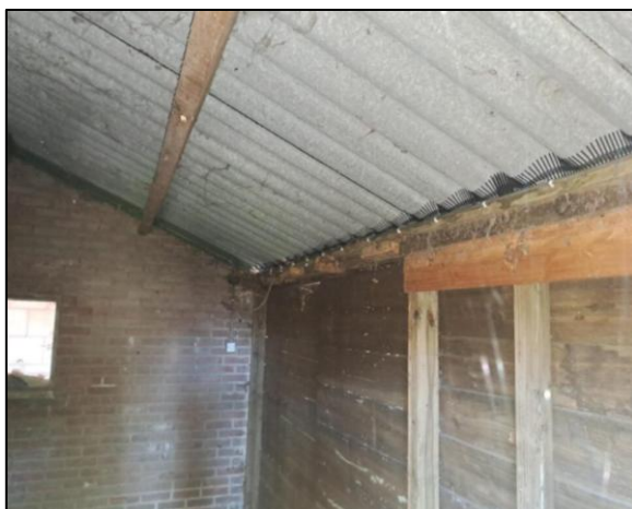
Foto links: opening in het metselwerk van de vrijstaande schuur dat voorzien is van kippengaas. Foto rechts: faunarasters onder deel van golfplaten van overkapping aan de westelijk gelegen te slopen stal.
