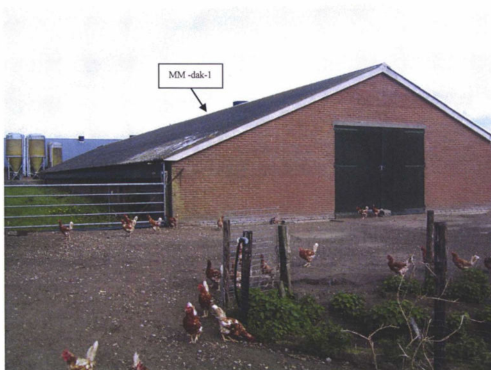
Foto 2 : Geïnvventariseerde pluimveestal met asbesthoudende golfplaat als dakbedekking vanuit zuidelijke richting gezien
