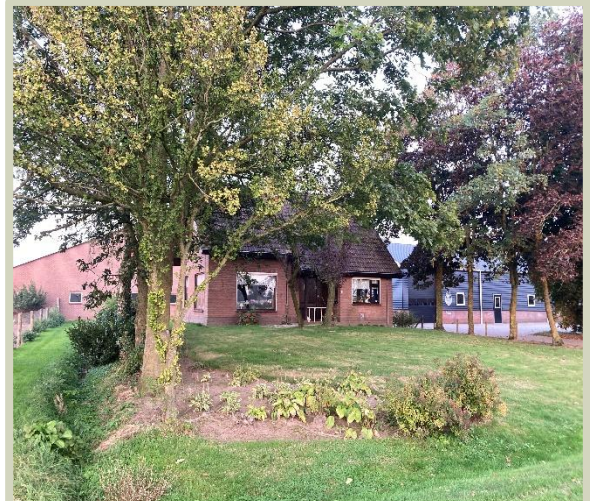
afb. 3 Woning Nieuw Hofweg 1
