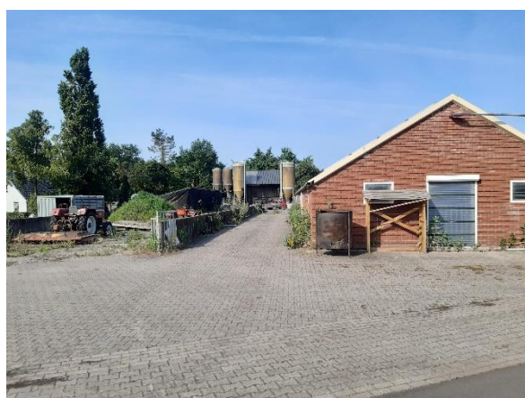
Foto 10: Aanwezige verharding buitenterrein, gezien vanaf de Haarweg
