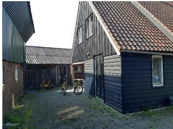
Foto 2: Achterzijde woning met op de achtergrond de stal met asbestverdachte dakbedekking
