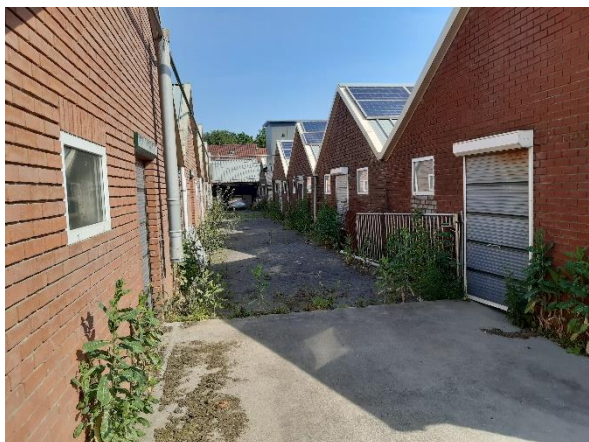
Foto 5: Aanwezige verharding (klinkers en beton) tussen de stallen
