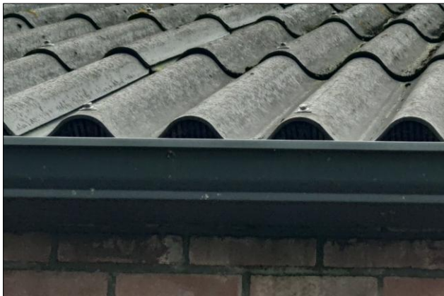
Detail opname dakplaten met faunawerend raster.
