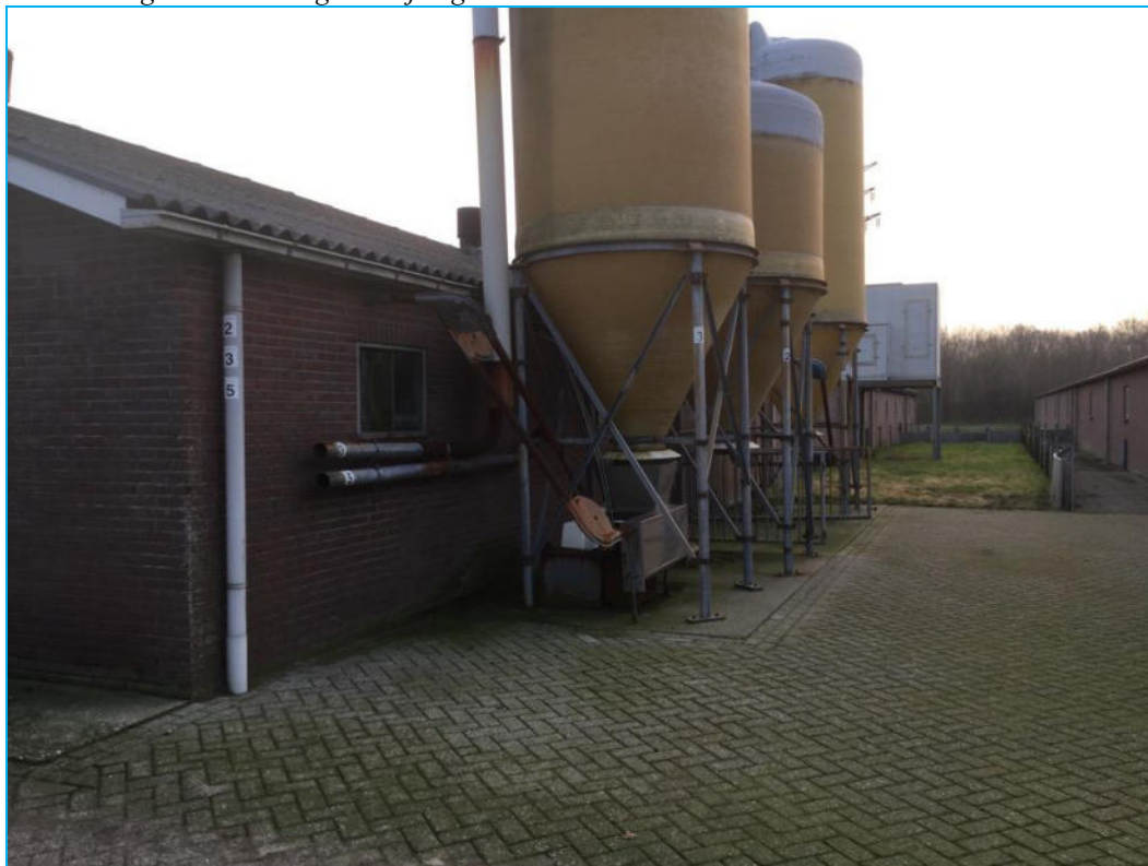
Foto 1: dakgoot/verharding westzijde gebouw E
