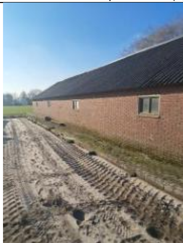
Foto's van de te slopen stallen (1)
