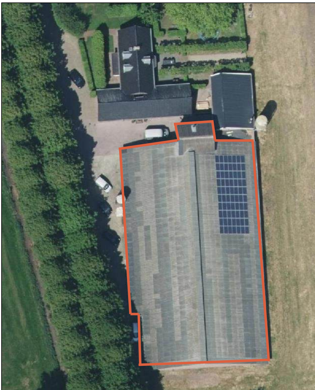
Afbakening onderzoekslocatie te slopen schuur
