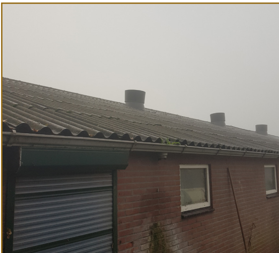
Afbeelding 2.5: De dakgoot sluit strak aan op de muur.
