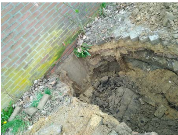
Foto 19: sleuf S5, geen puin onder fundering
