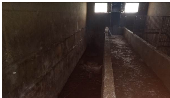
Foto 3: kelders in schuur Baron van Nagellstraat 78 (roosters niet meer aanwezig)
