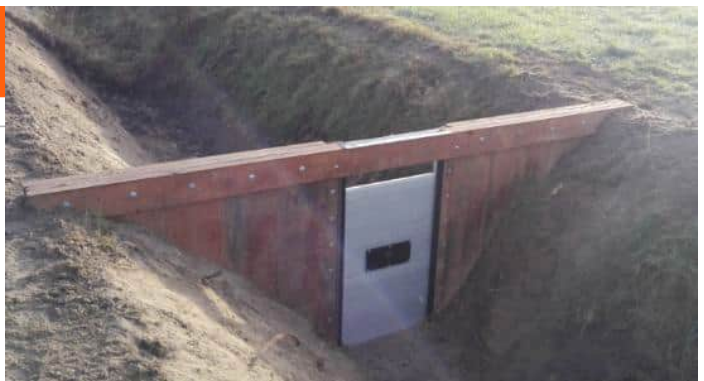
Afbeelding 1 principe stuw met schotbalkspinning / doorlaat
