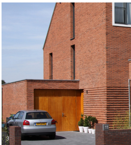
1. park 16Hoven, Rotterdam ©MIX Architectuur bv.
