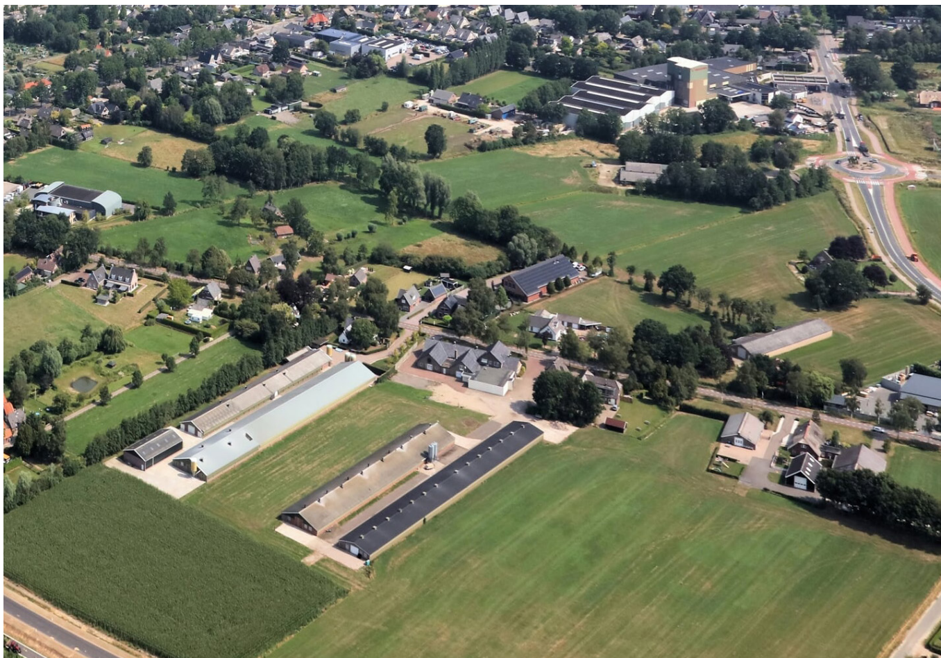
De Verbindingsweg met daarachter het projectgebied in vogelvlucht
