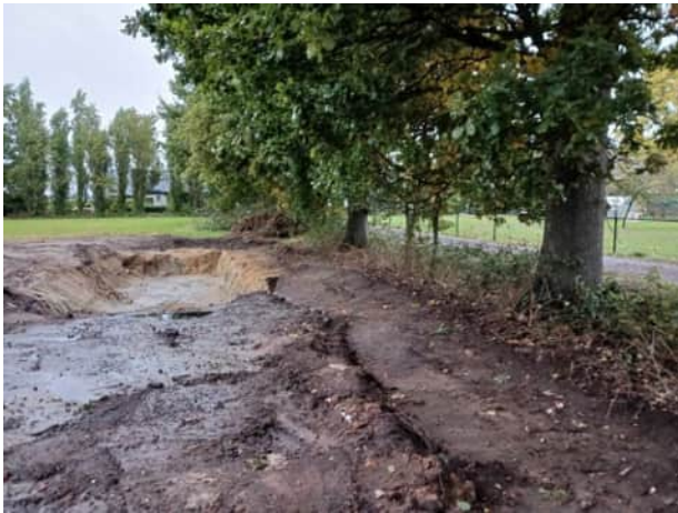
Figuur 3.29 Overzichtsfoto uitgevoerde graafwerkzaamheden
