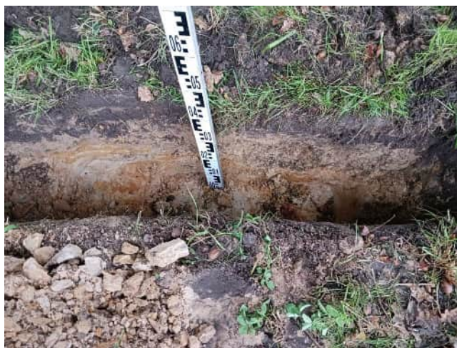
Figuur 3.28 Proefsleuf boom 303
