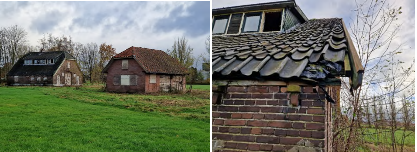
Figuur 25 Impressie van de potentiële nestplaatsen binnen het plangebied (deelgebied 6). Foto links: Overzicht van de te slopen gebouwen binnen deelgebied 6 die potentie hebben als nest- en rustplaats van steenuil en kerkuil. Foto rechts: Openingen bij één van de gebouwen binnen deelgebied 6 bij dakrand en kapot raam
