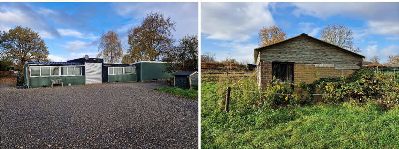
Figuur 8 Binnen deelgebied 1 zijn twee gebouwen aanwezig
