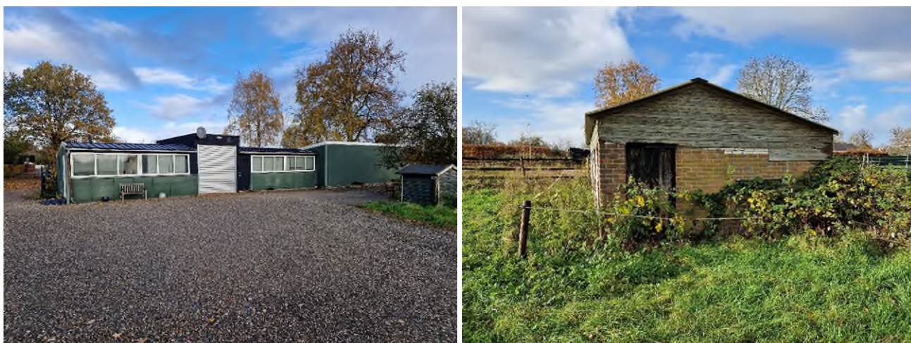
Figuur 25 Binnen deelgebied 1 zijn twee gebouwen aanwezig
