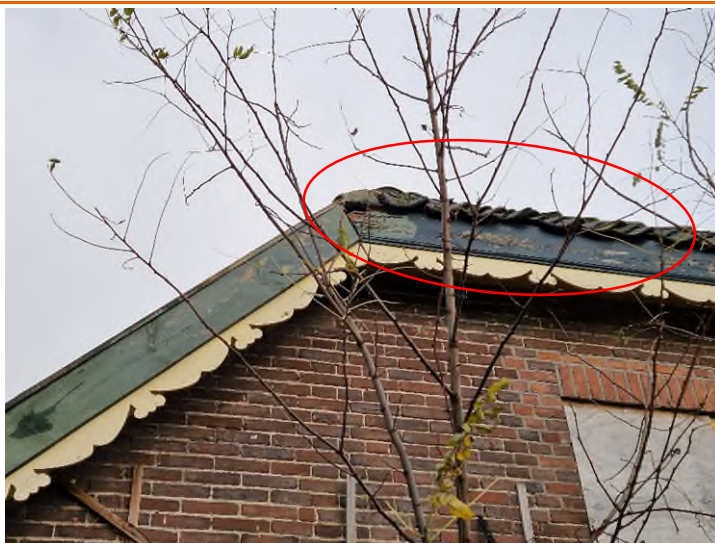
Figuur 14 Gebouw binnen deelgebied 6, ten noorden van Verbindingsweg 19, waar toegankelijke wegkruipruimtes bij de dakrand aanwezig zijn (rood omcirkeld); aanwezigheid van verblijfplaatsen van vleermuizen is niet uitgesloten.
