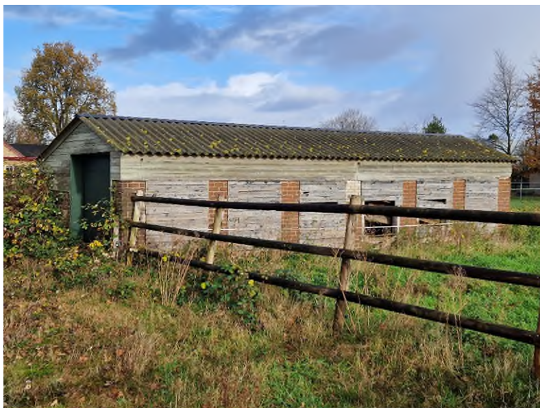
Figuur 6 Een schuur binnen deelgebied 1, ten zuiden van Hoofdstraat 44, vormt een potentiële nest- en rustplaats van huismus, kerkuil en steenuil.
