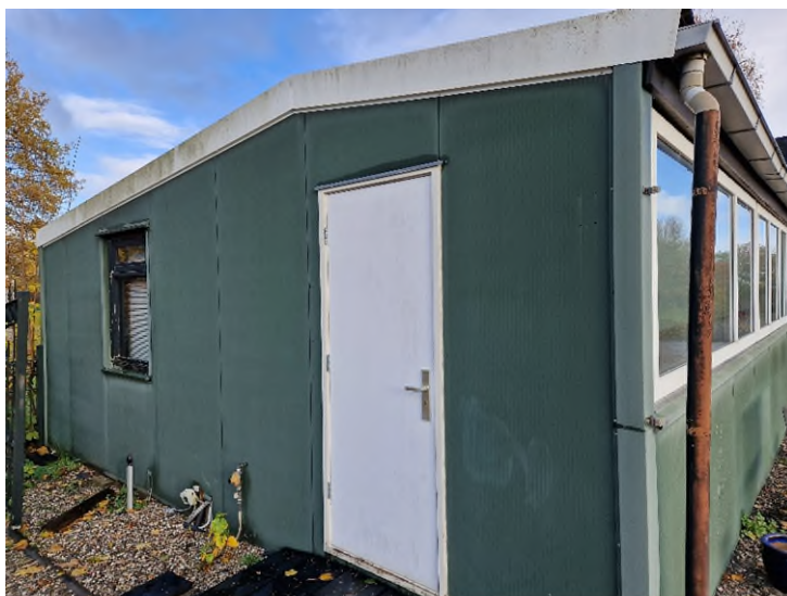
Figuur 15 Een gebouw binnen deelgebied 1, ten zuiden van Hoofdstraat 36, heeft geen wegkruipruimtes; aanwezigheid van verblijfplaatsen van vleermuizen is uitgesloten.
