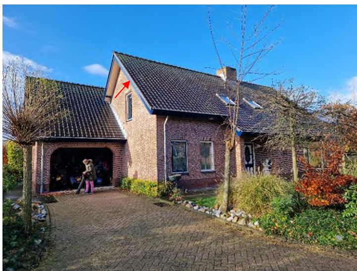
Figuur 17 Een woning binnen deelgebied 2, ter hoogte van de Zwarteweg, is voor vleermuizen toegankelijk ter hoogte van de dakrand (zie rode pijl); aanwezigheid van verblijfplaatsen is niet uitgesloten.
