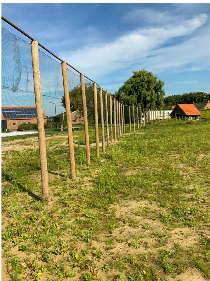
Figuur 2. Voor het behoud van de vliegroute worden vleermuisschermen van Jos Kanters Groenvoorziening toegepast (Beeldmateriaal: Jos Kanters Groenvoorziening). Bovenstaand betreft een voorbeeld van een vleermuisscherm die niet aan de hoogte-eis van de laatvlieger voldoet.
