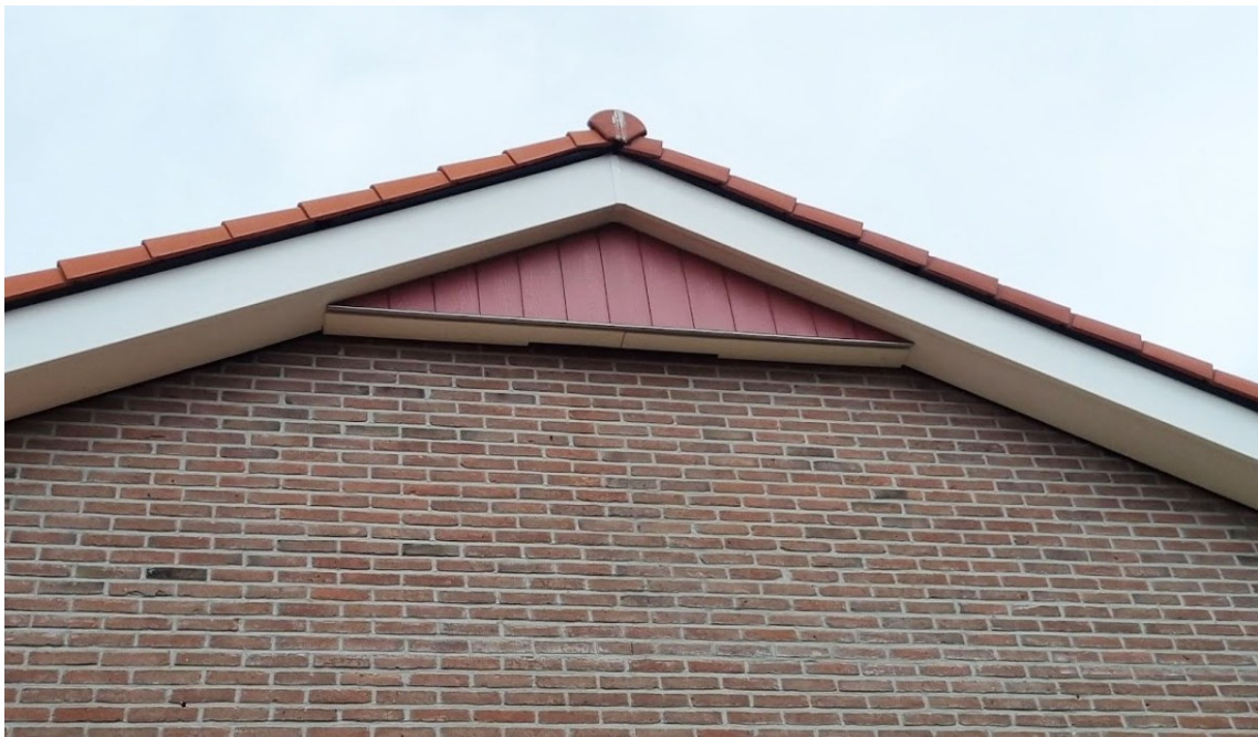
Figuur 4. Vleermuiskast VMN1 van Unitura of een gelijkwaardig type meerlaagse gevelbetimmering wordt toegepast voor de gewone grootoorvleermuis (Beeldmateriaal: Unitura).
