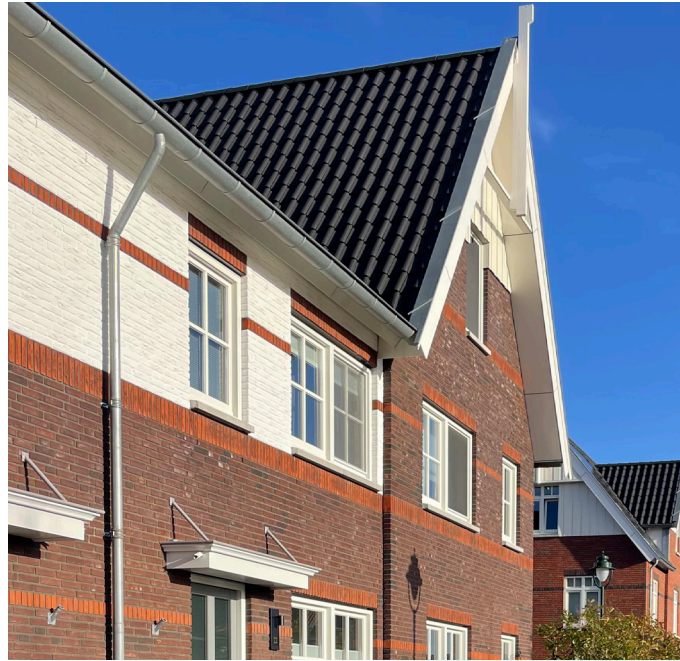
Beëindiging rij met draaien nokrichting
