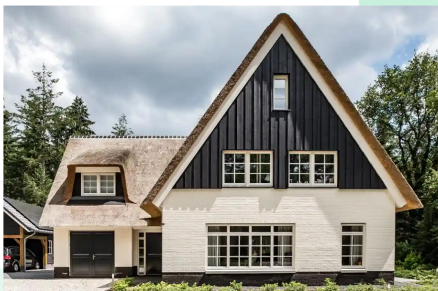
2. De Rieten villa Rieten kap en lage 'goot'
