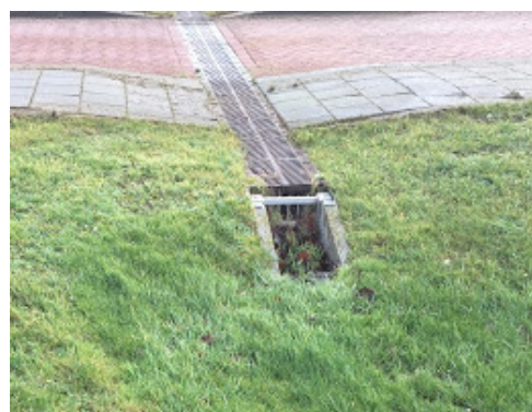
Beperken verhardingen in openbare ruimte; groenvakken, parkeren op grassteen, afvoer richting groen en halfverharde wandelpaden
