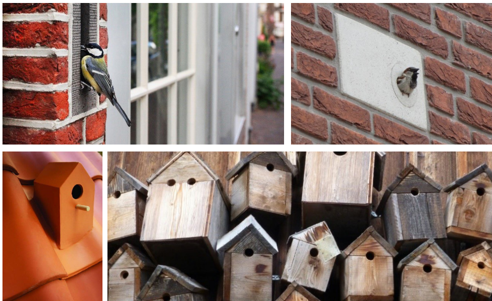
Natuurinclusief bouwen met geïntegreerde nestkasten
