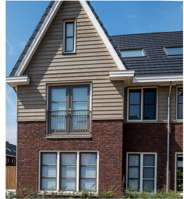
Frans balkon op de verdieping
