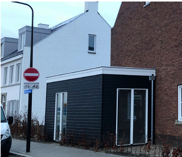
Aanbouw in hout
