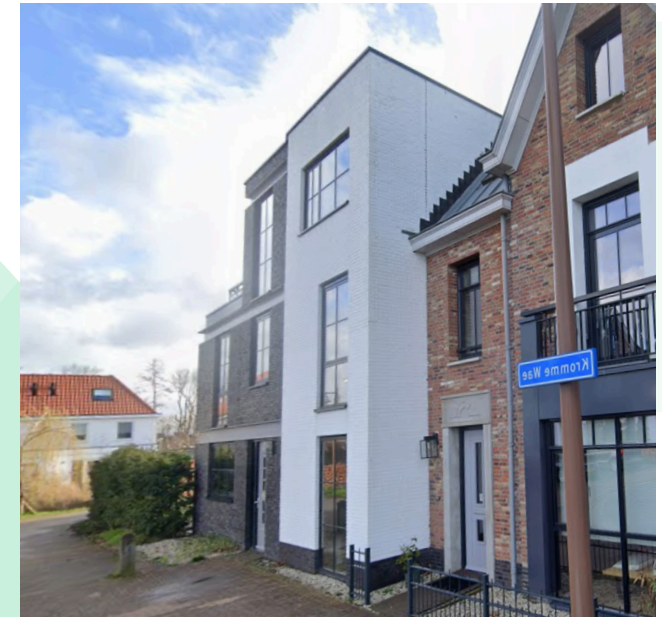
5. Het Hoekhuis Als eerste/laatste woning van de rij, met een plat dak en afwijkend in kleur en materiaal
