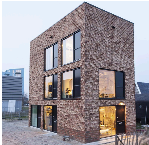
4. Het Hoge huis Plat afgedekte woning van 3 lagen met een 'smalle' voorgevel
