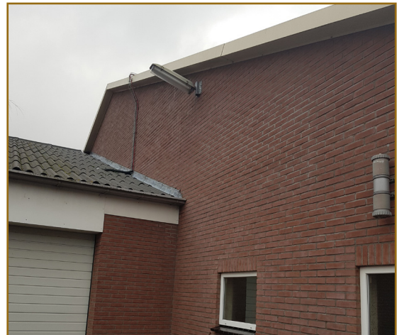
Afbeelding 2.4: Het overstek sluit strak aan op de muur aan de kopse kanten van beide schuren. Deze foto betreft de westelijke kopse kant van de noordelijke schuur.
