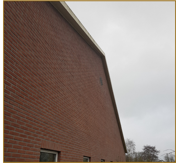
Afbeelding 2.2: Het overstek sluit strak aan op de muur aan de kopse kanten van beide schuren. Deze foto betreft de oostelijke kopse kant van de zuidelijke schuur.
