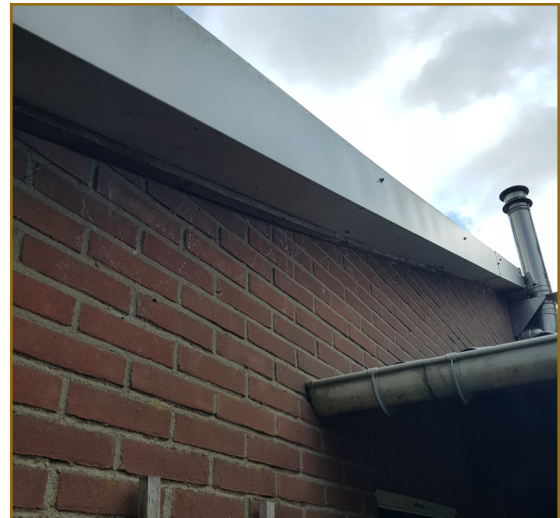
Afbeelding 2.4: Het overstek van schuur D sluit strak aan op de muur.
