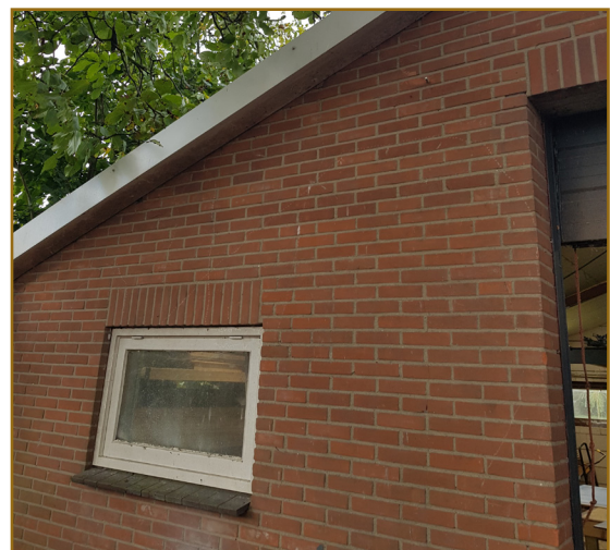
Afbeelding 2.6: Het overstek van schuur D sluit strak aan op de muur.
