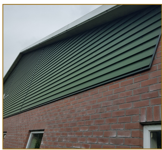
Afbeelding 2.10: Deels metalen wandbeplating van schuur A. Deze sluit strak aan op de bakstenen muur.
