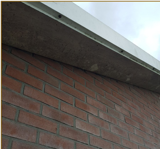
Afbeelding 2.9: Het overstek van schuur A sluit strak aan op de muur.
