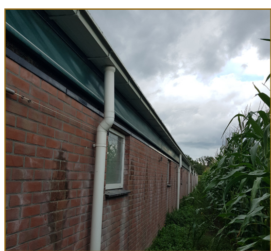
Afbeelding 2.12: De metalen raamconstructie van schuur A sluit strak aan op de bakstenen muur.
