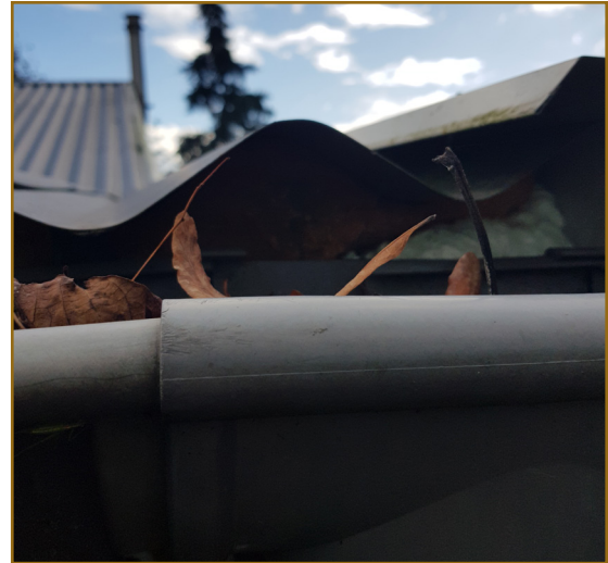
Afbeelding 2.2: Isolatie onder de golfplaten van schuur D en E.
