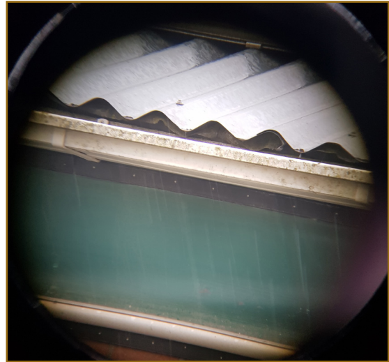
Afbeelding 2.8: Plastic van de isolatie sluit de ruimte onder de golfplaten van schuur A af.
