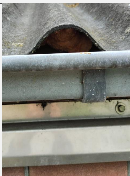
Dakvlak bestaat uit golfplaat – De golfopeningen zijn gevuld met isolatieschuim.
