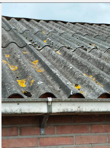
Dakvlak bestaat uit golfplaat – De golfopeningen zijn gevuld met isolatieschuim.
