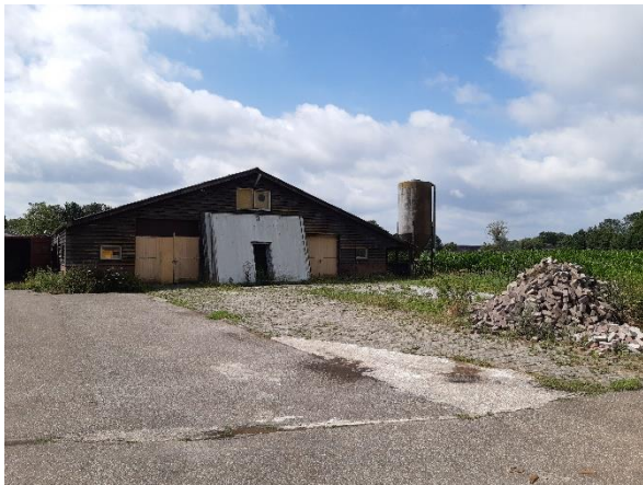
Foto 1: Aanwezige kippenschuur met aan de voorzijde de verharding bestaande uit asfalt en klinkers.
