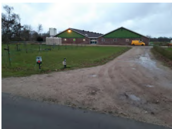
Foto 5: Toerit van menggranulaat en de kalverenschuren
